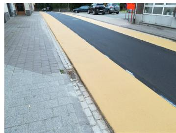
Une bande cyclable suggérée n'est pas une piste cyclable ! Les bandes cyclables suggérées sont aménagées sur le côté de la route et indiquées dans une couleur autre que celle de la chaussée (gris, vert, ocre ou rouge). Elles sont également réalisées dans un autre matériau. Des pictogrammes de vélos sont quelquefois apposés sur le sol.
